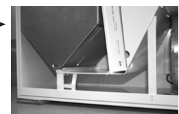
By-pass spjæld ved vinterdrift Spjældet sættes til sommerdrift ved at trække låseskiven mod dig selv.
